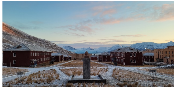
Pyramiden. Branntilsyn med Sysselmesteren
