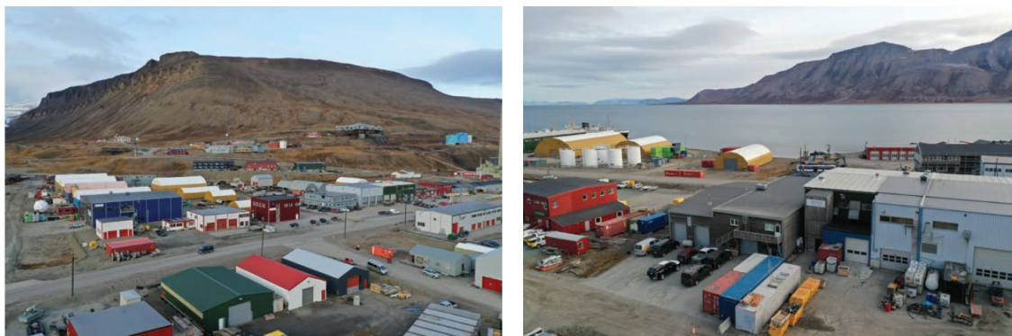
Figur 5: Til venstre: Området sett fra nordøst opp mot Platåberget. Til høyre: Deler av felt F/N3 sett fra sør. Kilde: LPO arkitekter.
