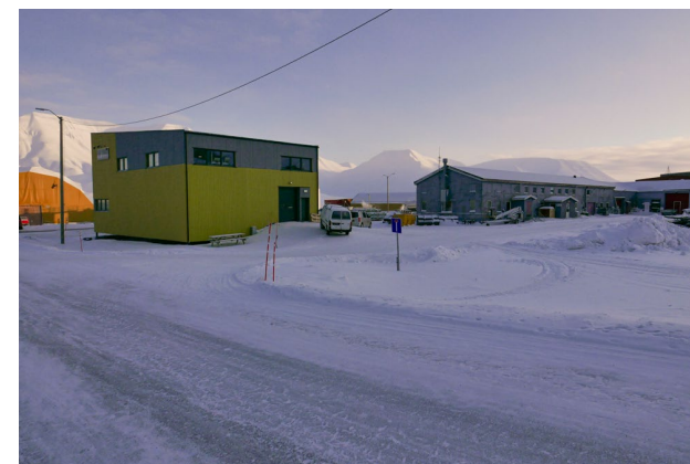
Område 1, sett mot nord.
