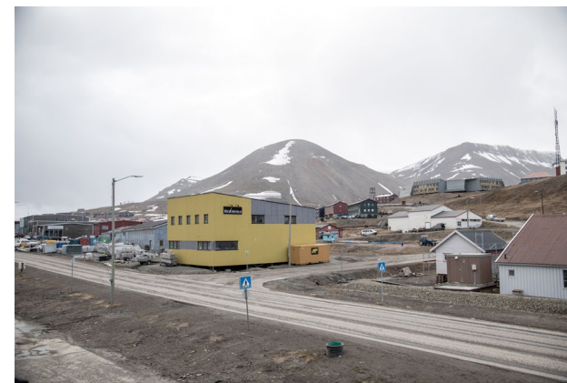
Området sett fra øst med vei 600 i forkant.
