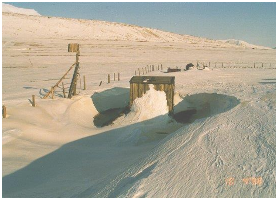
Figur 11 Bildet viser typiske snøfonner rundt en bygning. Fotografen står på en av sidefonnene og ser mot lesonefonnen. Bak bygningen ligger lofonn.
