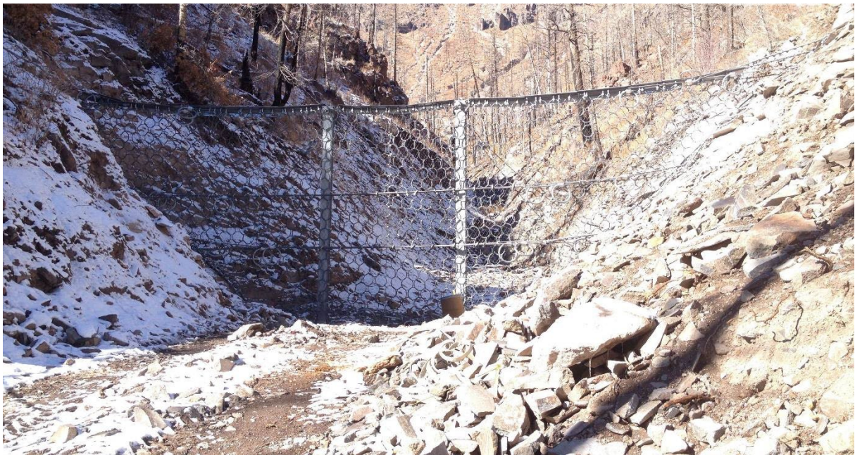
Figur 14: Eksempel på nett som er brukt som sikring mot flomskred. I dette eksempel er det kort avstand mellom dalbunn og nedre del av nettet. Foto fra Geobrugg.
