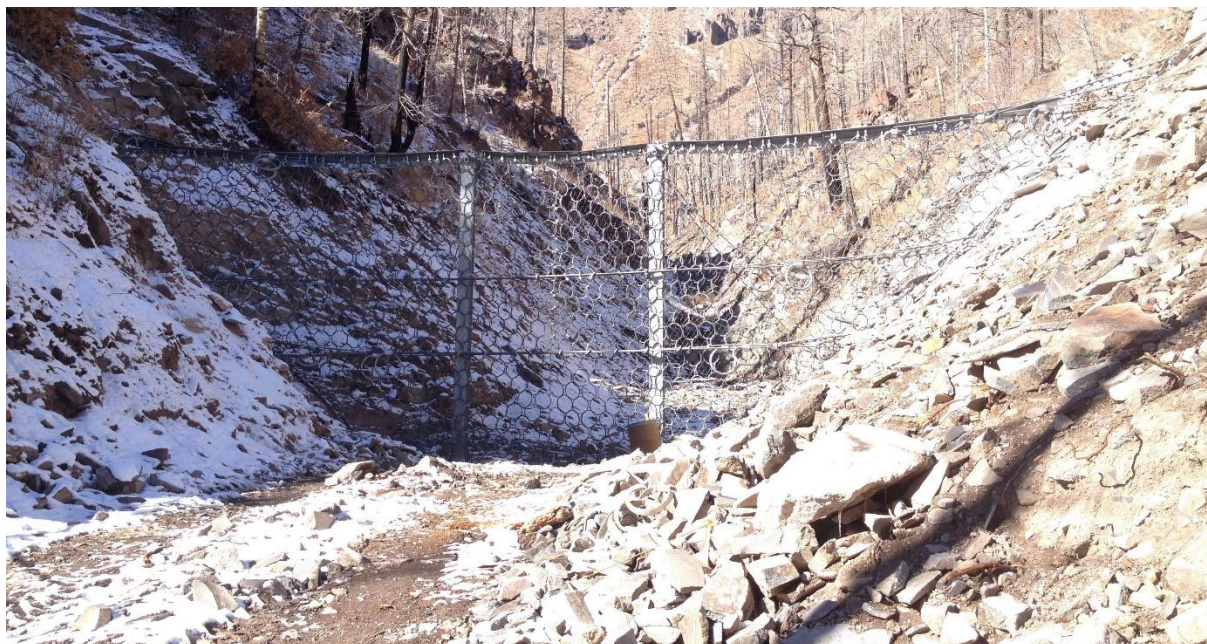
Figur 5: Eksempel på nett som er brukt som sikring mot flomskred. I dette eksempel er det kort avstand mellom dalbunn og nedre del av nettet. Foto fra Geobrugg.
