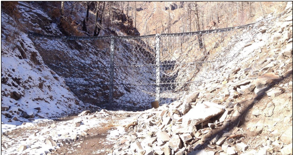
Figur 1: Eksempel på nett som er brukt som sikring mot flomskred. I dette eksempel er det kort avstand mellom dalbunn og nedre del av nettet. Foto fra Geobrugg.
