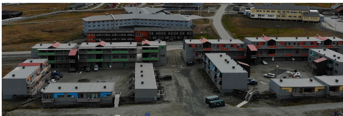
Bilde: Felt B1 har adkomst mellom bygningene i B/N3. Parkeringsplassen midt i bildet benyttes delvis, men parkering skjer også inne i atriene. Foto: Dag Ivar Brekke
