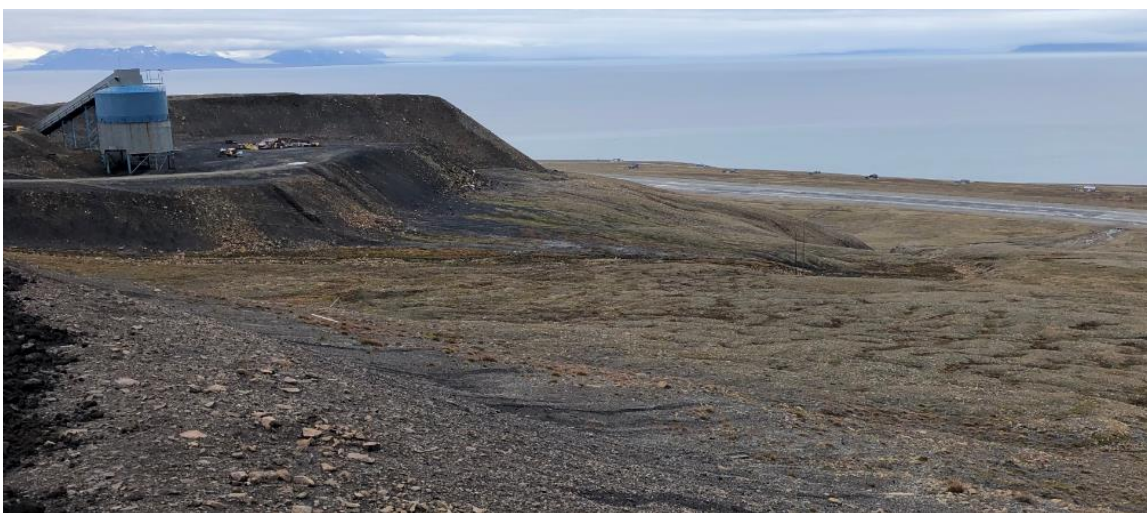
Bilde 2: Massetipper ved Gruve 3 med deponialternativ 1 til høyre (Norconsult AS)
