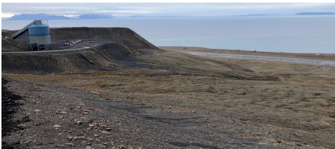
Figur 3-3 Massetipper ved Gruve 3 med deponialternativ 1 til høyre.
