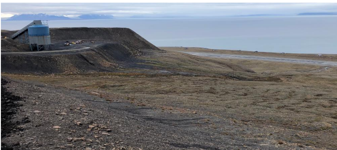
Figur 3-3 Massetipper ved Gruve 3 med deponialternativ 1 til høyre.
