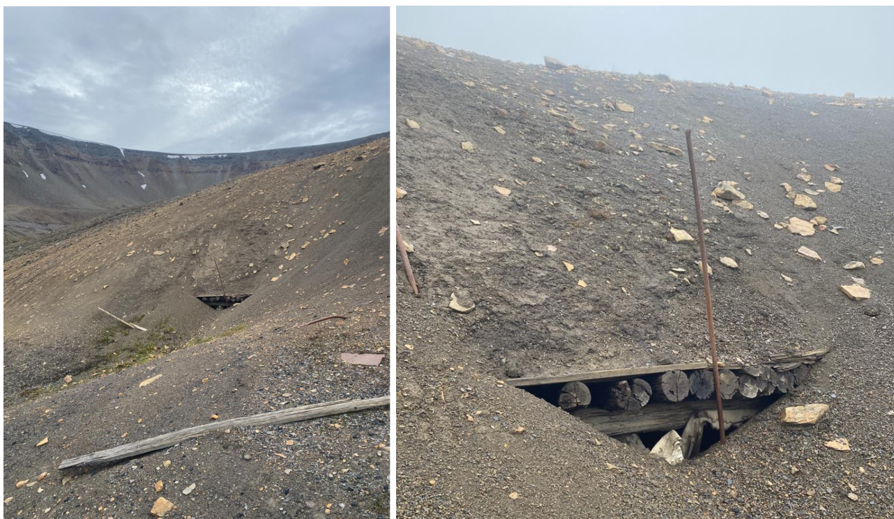
Figur 4-7 Inngangen til gruvestollen (158584)
