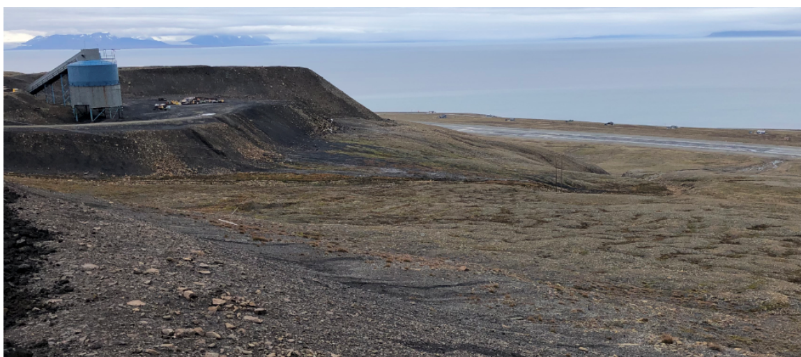
Figur 3.3 Massetipper ved Gruve 3 med deponialternativ 1 til høyre.
