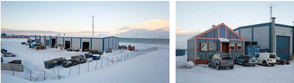
Figur 9: Avfallsmottaket (t.v.) med tilhørende driftsbygning (t.h.).
