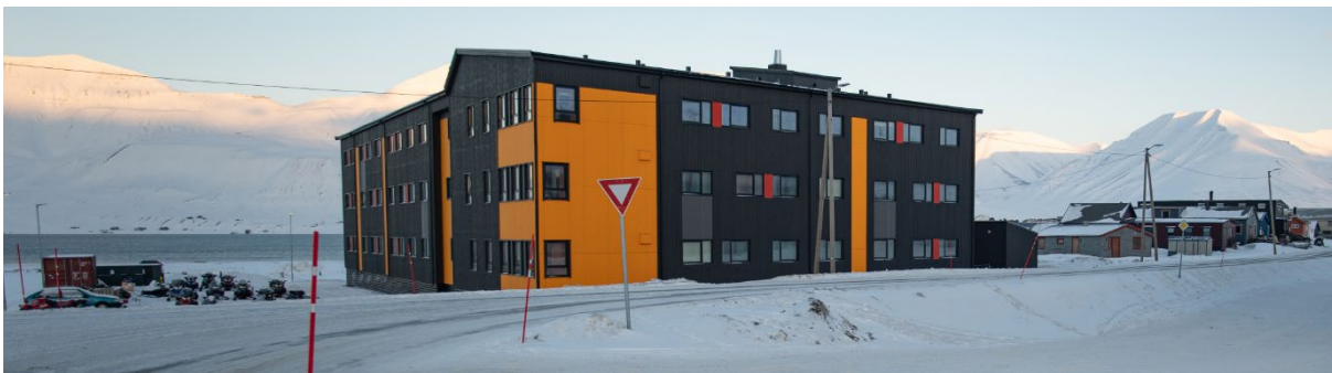
Figur 10: Studentboliger sett mot nord-øst.
