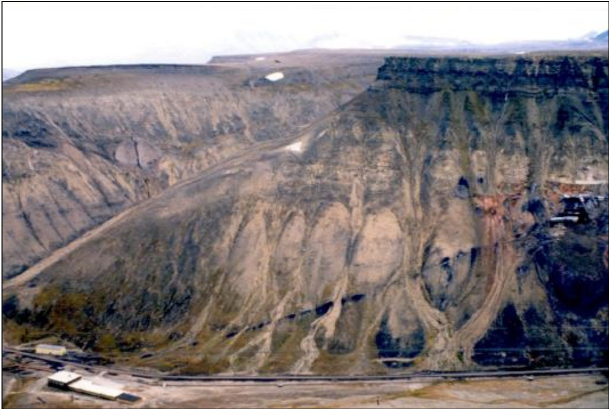
Figur 7: Bilde hentet fra NGI (1993) og ble tatt i 1985. Bildet viser skredbanene og utløpsområdene til jord- og flomskred. Skredmassene har stedvis nådd helt ned til veien.
