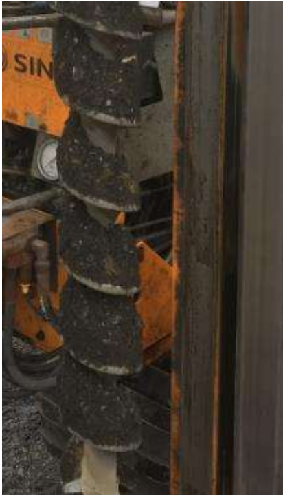
Figur 3 Augerboring (Bildet er fra et annet prosjekt)
