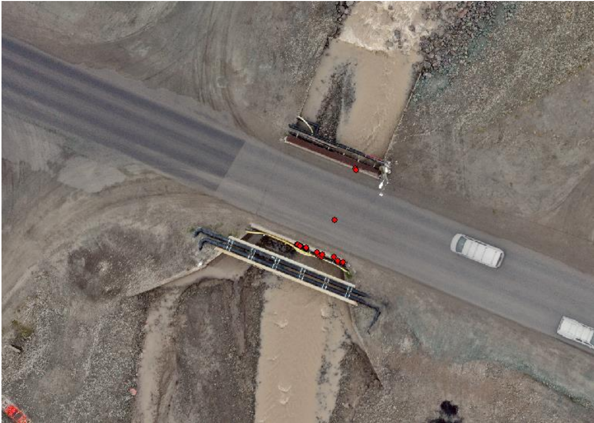
Figur 4. Innmålinger (i rødt) av bru/kulverter ved Vei 600.
