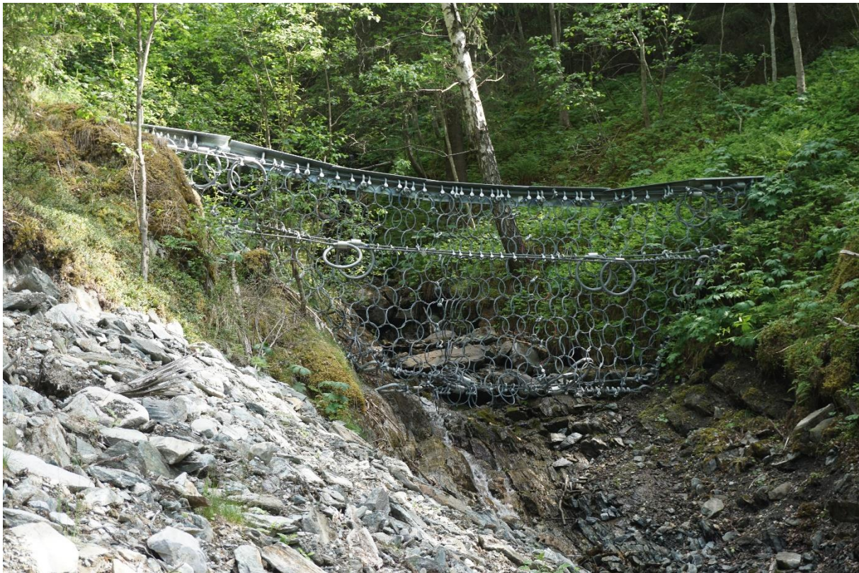
Figur 9: Eksempel på fangnett mot flomskred fra Kollobekken, Otta.
