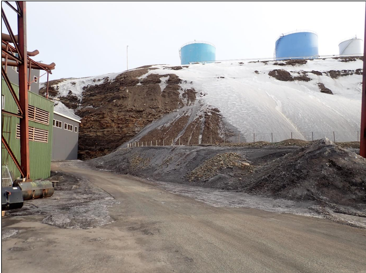
Figur 7: Foto av bergskjæring, løsmasseskråning og oppsamlingsbasseng (forgrunn). Bildet er tatt ved innkjørselen til energiverket.
