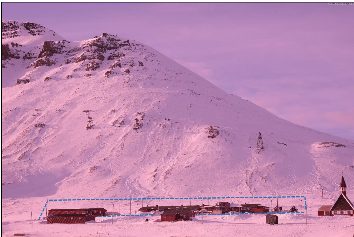
Figur 1: Foto av den vurderte fjellsiden (Kilde: regobs.no, Audun@unis, 21.03.2019). Vurdert område er bebyggelsen i bakkant av bildet, og er skissert med stiptet linje. Kirken til høyre i bildet.
