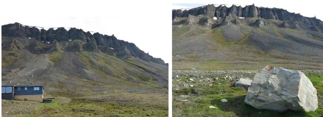
Bilde 15: Område utsatt for steinsprang. Store steinblokker har nådd til nedsiden av veien. Sett mot øst.
