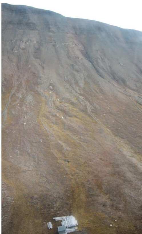
Bilde 34. Viser området mot hytte på Revneset der det potensielt kan være fare for steinsprang. Sett mot øst.
