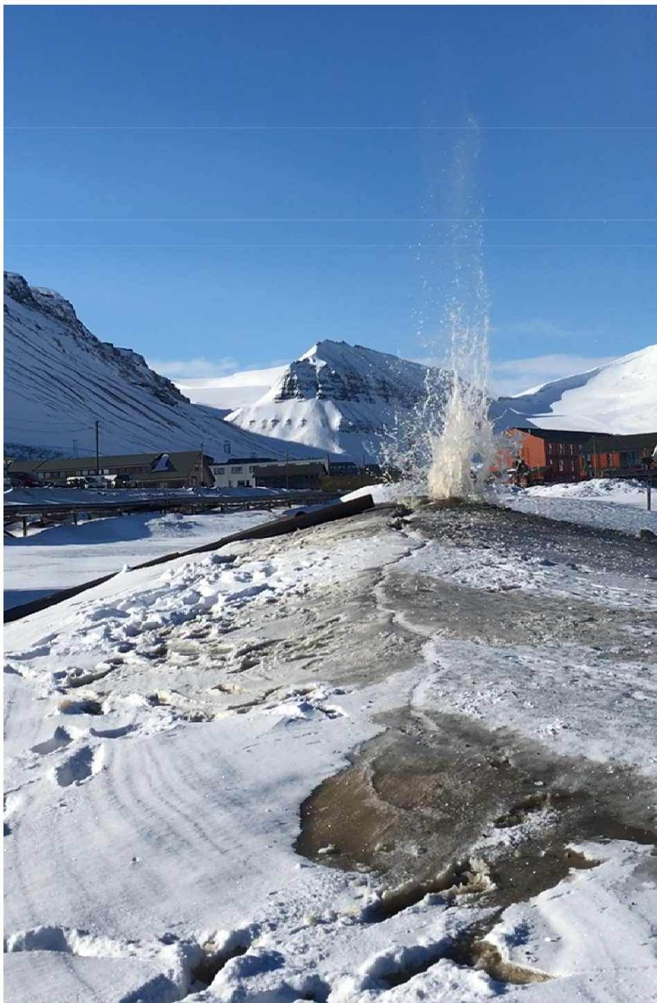
Figur 6: Vann ved borpunkt IS_1, under boring av punkt IS_2
