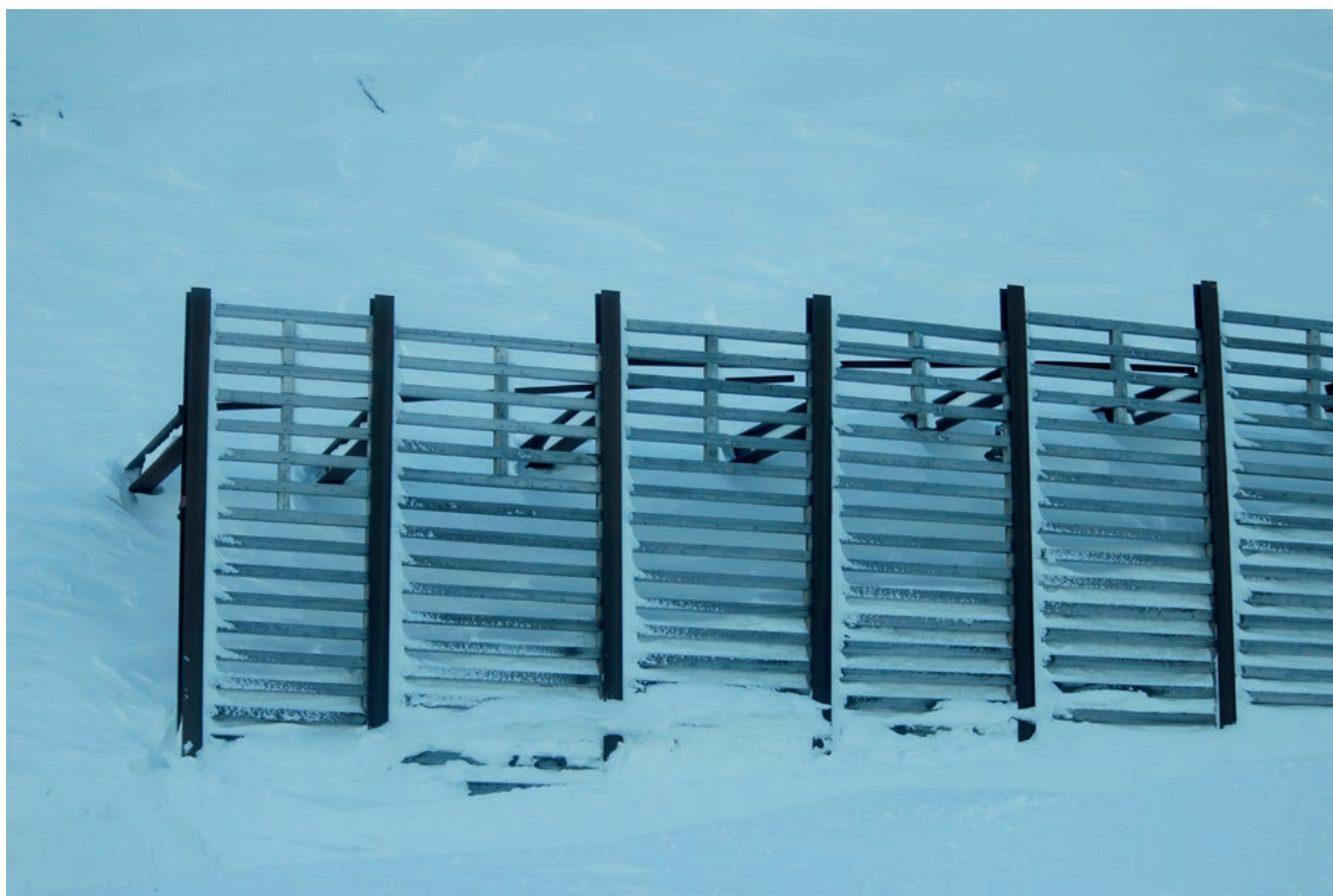
Skredsikring. Foto: Sofie Grøntvedt Railo
